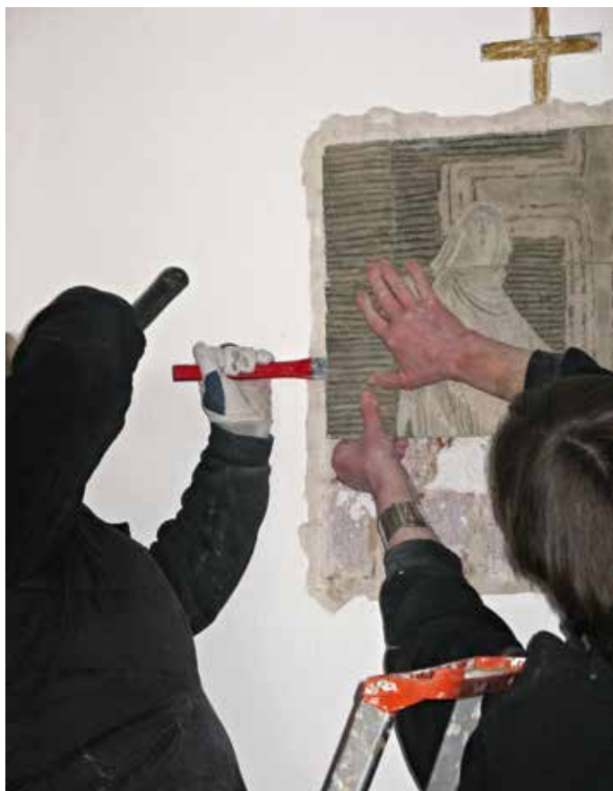
6 Ausbau des Kreuzwegs von Ruth Landmann von 1967 aus der 2010 profanierten Kirche St. Johannes Ev. in Bad Eilsen
