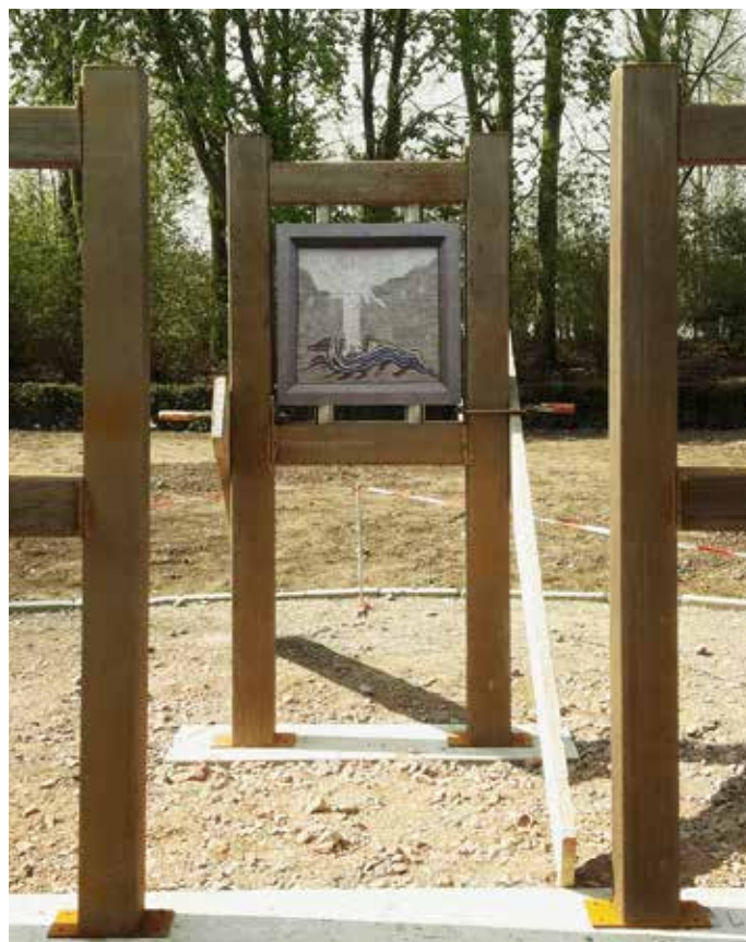
9 Neuaufstellung von Teilen des Kreuzwegs in Holzgerüsten auf dem Hauptfriedhof in Datteln 2019
